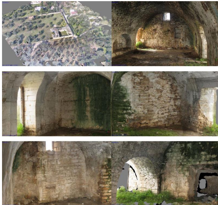
Nuvola di punti e mesh ottenute attraverso tecnica fotogrammetrica (tesi di Domenico Modugno, Il rilievo del costruito nel BIM, 2016)
